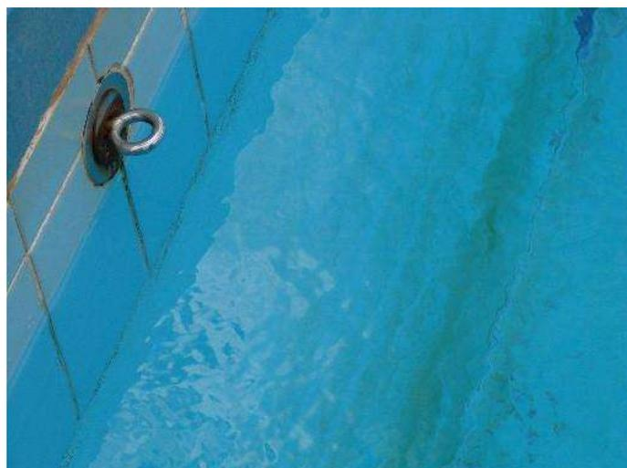
RUSTED LANE ROPE ANCHORS 50M POOL
